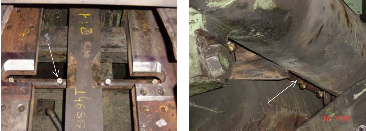
Figura 6. Detalhe da montagem dos chuveiros da entrada das cadeiras F2 e F3.
