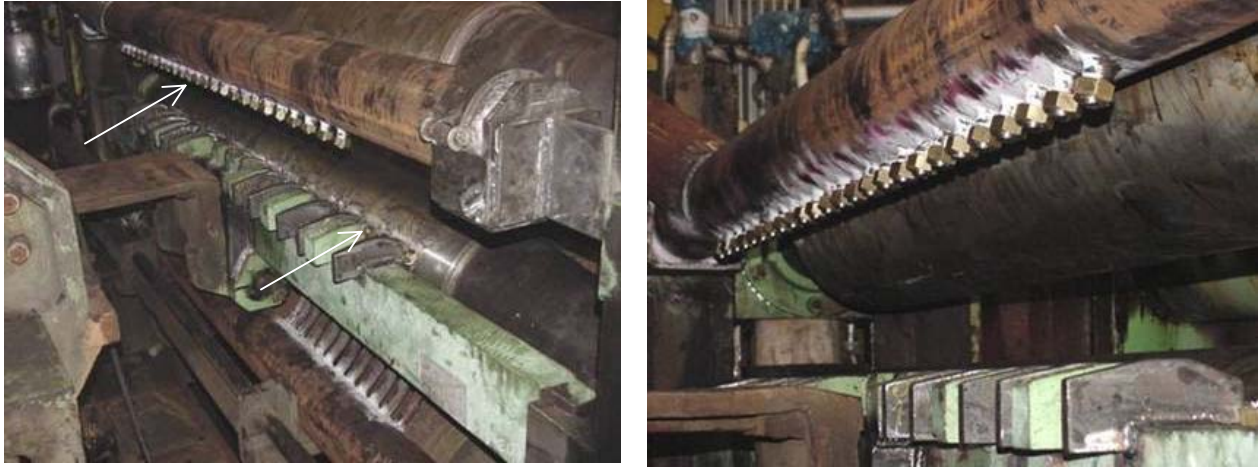
Figura 4. Sistema de Resfriamento de Superfície de Esboço.
