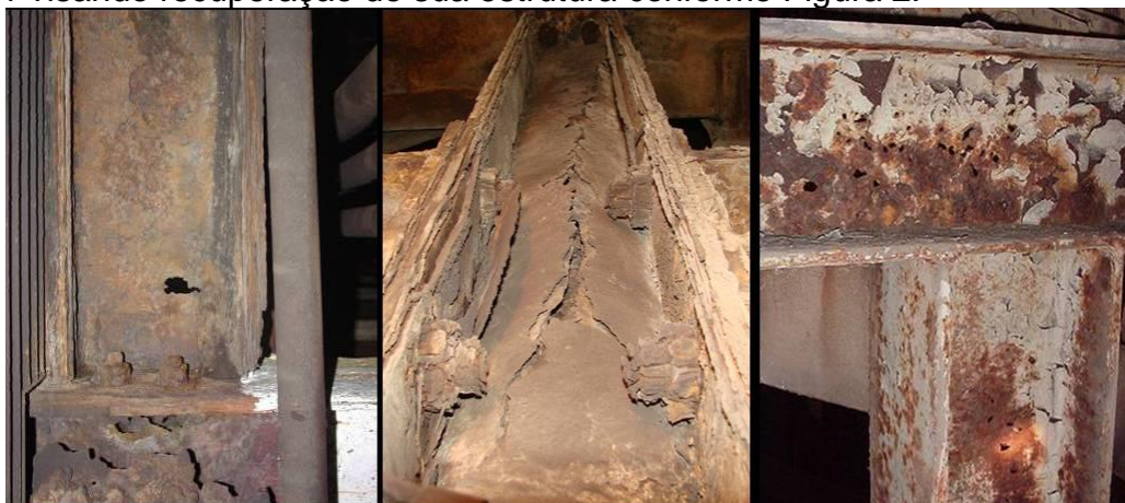
Figura 2. Partes da estrutura da MLC#1 substituídas em 2012
