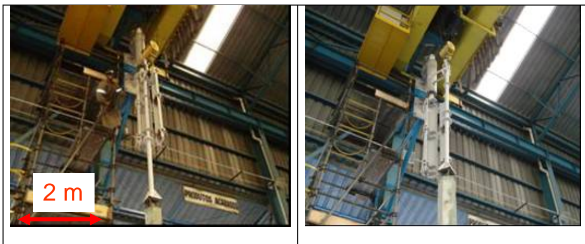
Figura 5: Estação de teste do sistema de dessulfuração SIRI instalado na unidade da Magnesita em Coronel Fabriciano.
