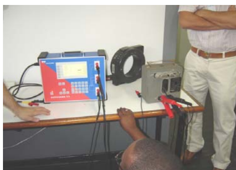
Figura 6: Equipamento para testes em TC'S.
