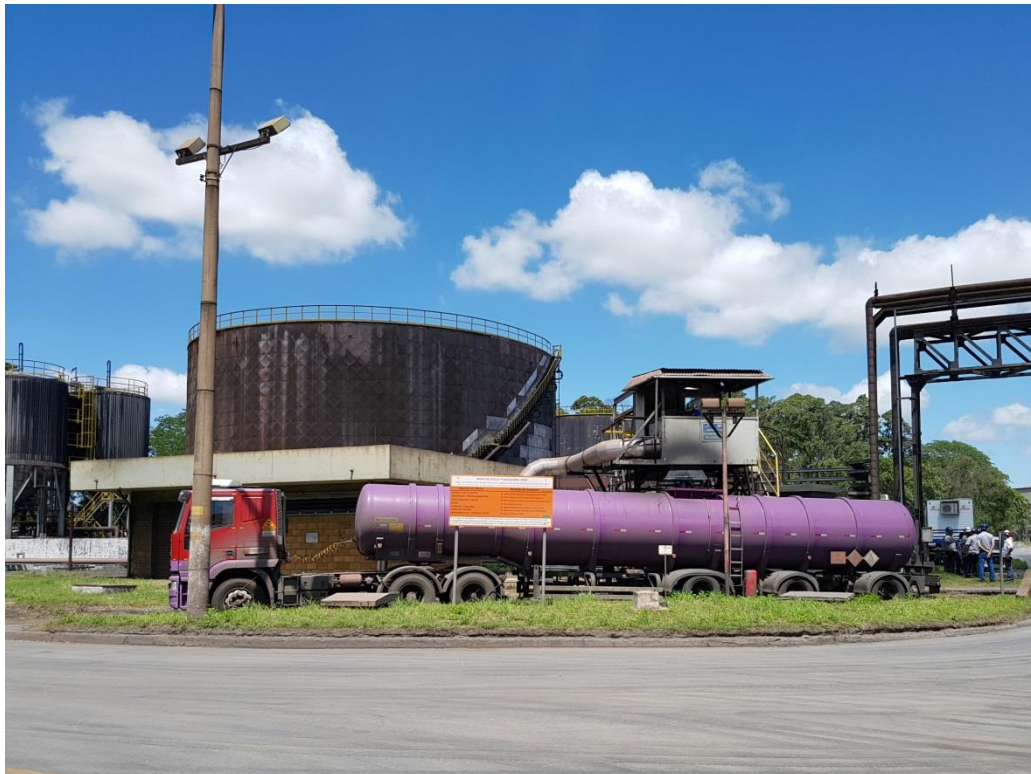
Figura 3 – Sistema de Carregamento de Alcatrão
