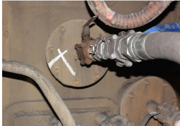
Figura 8. Fotografia da injeção da massa refratária em uma região do Alto-Forno 2.
