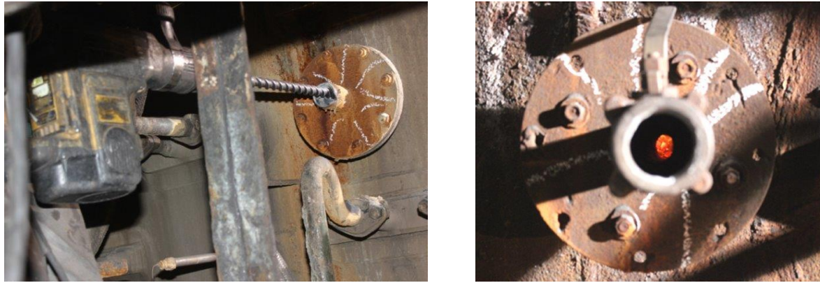
Figura 6. Fotografias evidenciando a confecção do canal de injeção de massa refratária.
