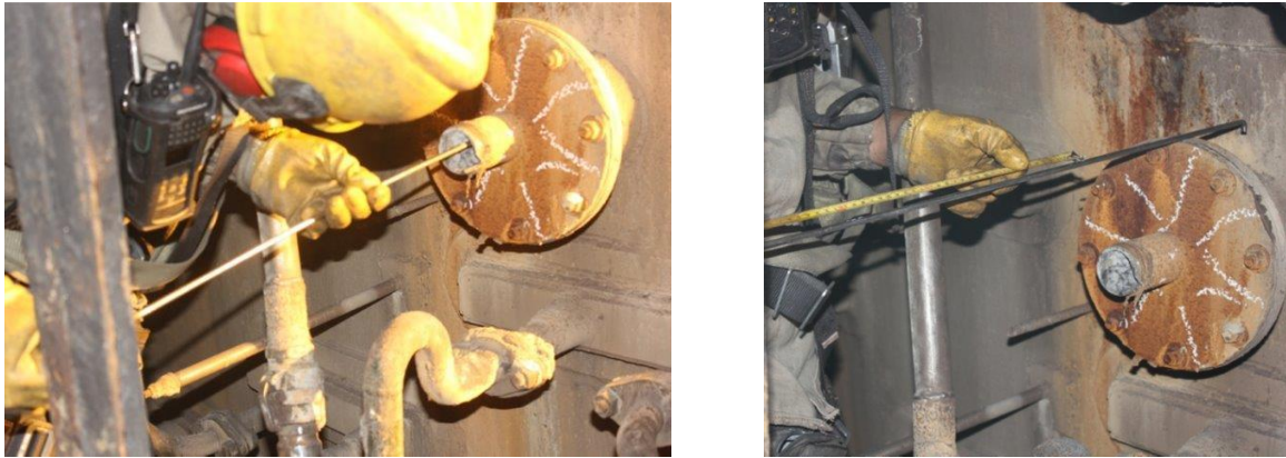
Figura 13. Fotografias do processo de medição da espessura de revestimento remanescente.
