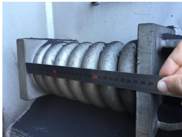
Figura 2. Medição das molas intermediárias dos Buckstays.
