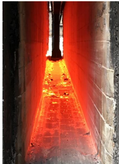
Figura 1. Inspeção visual dos fornos de Coqueria.
