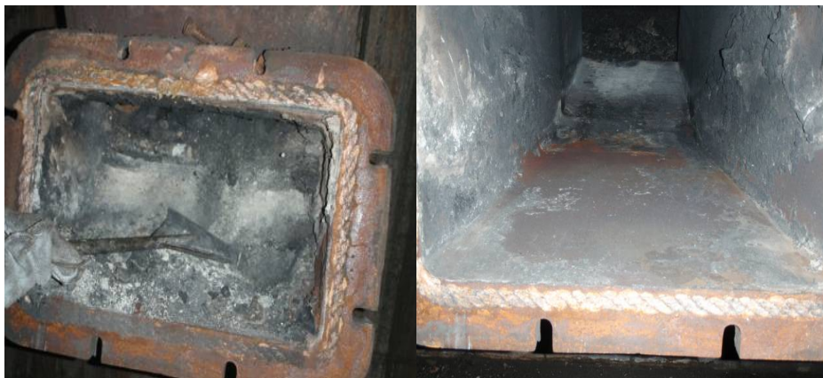
Figuras 12 (a) e (b): (a) Canal de fumaça antes da limpeza, (b) Canal de fumaça após limpeza.
