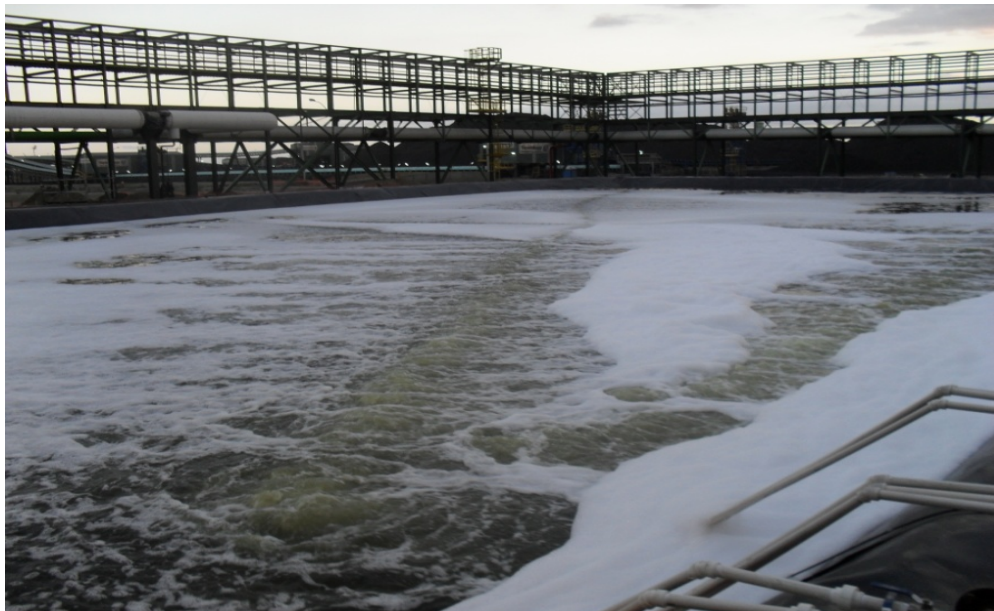
Figura 5: Aeração na Bacia de 5.000 m 3 com todo efluente da limpeza química
