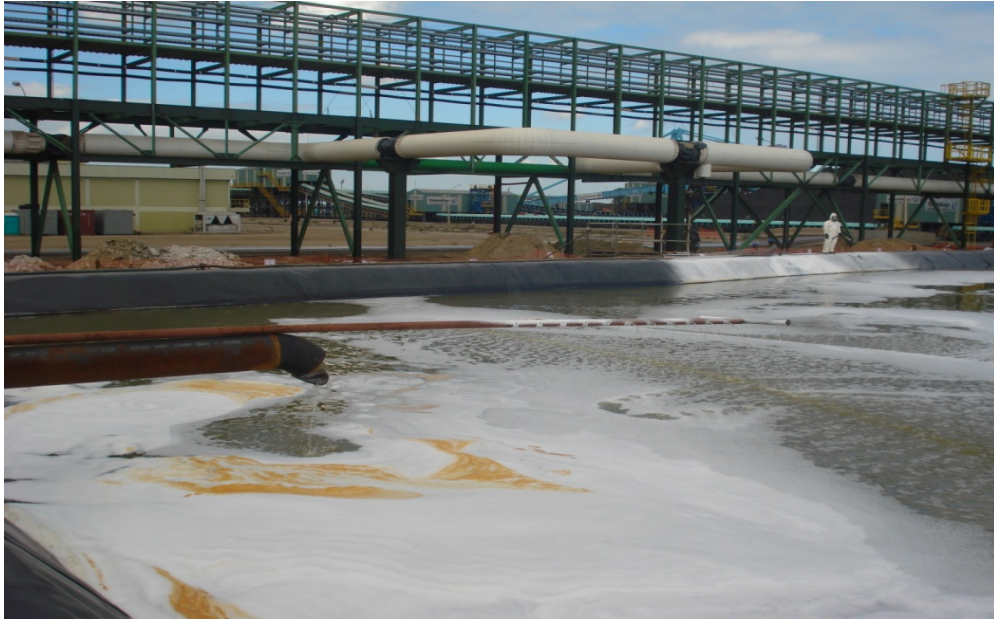
Figura 4: Dosagem de Hidróxido de Cálcio na Bacia de 5.000 m 3 para tratamento químico.
