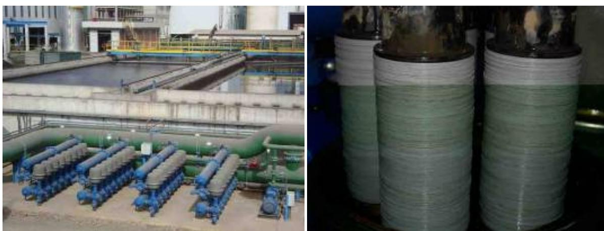
**Figura 11.** Filtros de Anéis – Bateria para Água de Contato / Detalhe das cabeças de anéis.
