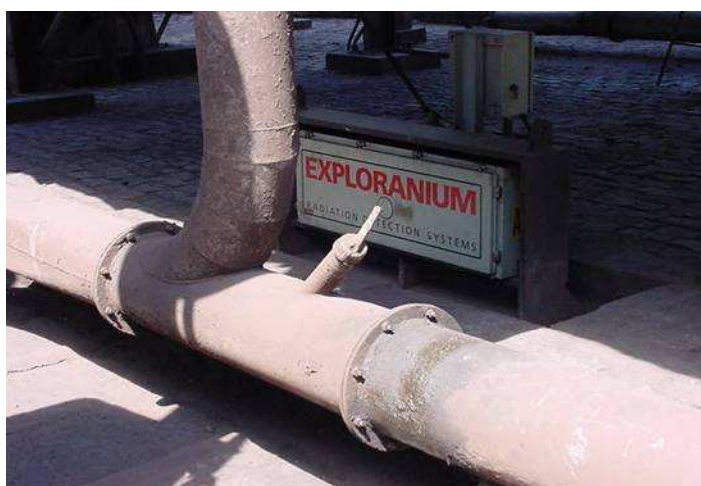
Figura 4. GR-606, 4ª linha de defesa de monitoramento no sistema de despoejamento da Aciaria.
