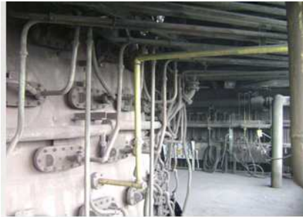
Figura 1: Interligação de 4 tomadas de N2 e 4 tomadas de vapor para inertização dos gases com PCI enriquecido devido ao abaixamento de carga.
