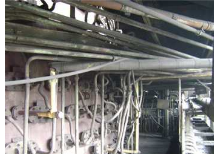
Figura 1: Interligação de 4 tomadas de N2 e 4 tomadas de vapor para inertização dos gases com PCI enriquecido devido ao abaixamento de carga.
