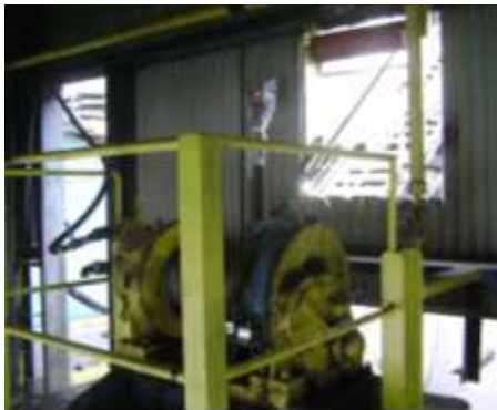
Figura 2: Instalação de sonda de nível manual pneumática de emergência com alcance de 25 metros.
