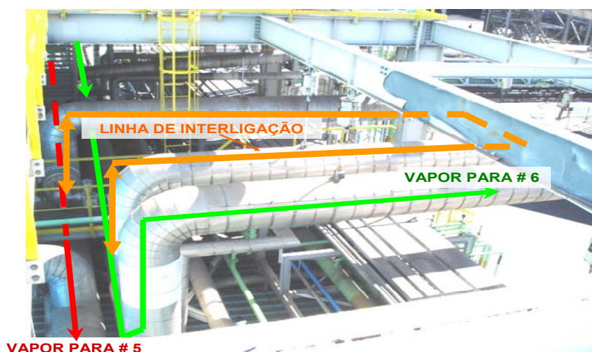
Figura 2 – Interligação de vapor TGs 5 e 6.
