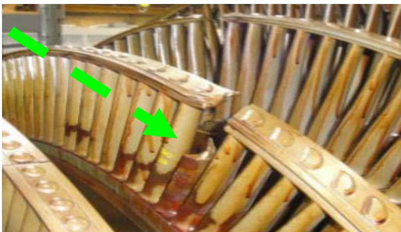
Figura 1 -Exemplo de dano causado em turbina por contaminantes no vapor.
