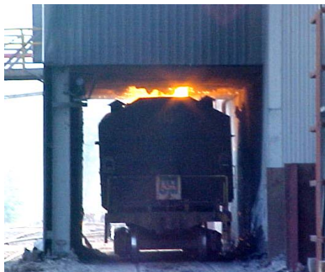
Figura 6 – Dessulfuração de gusa dentro de carros torpedo na Usiminas – Planta Usina II.
