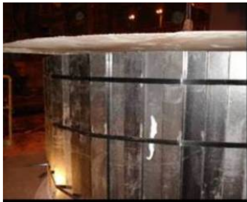
Figura 16 - Cintagem dos tijolos do fundo do MRP-L
