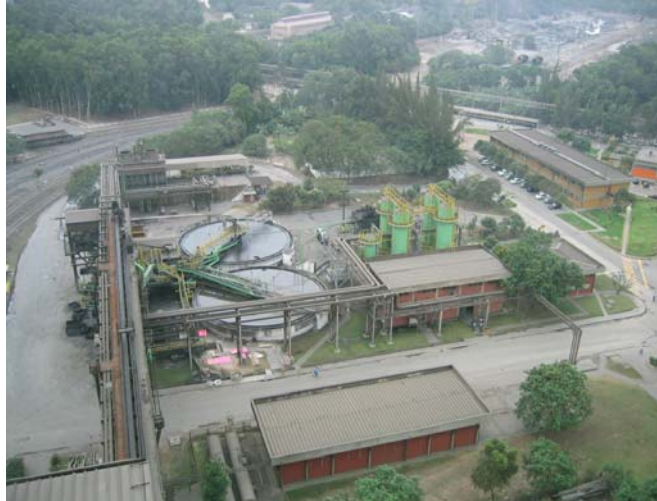
Figura 3a: Foto da Central de Recirculação de Água da Aciaria (CRACIA)
