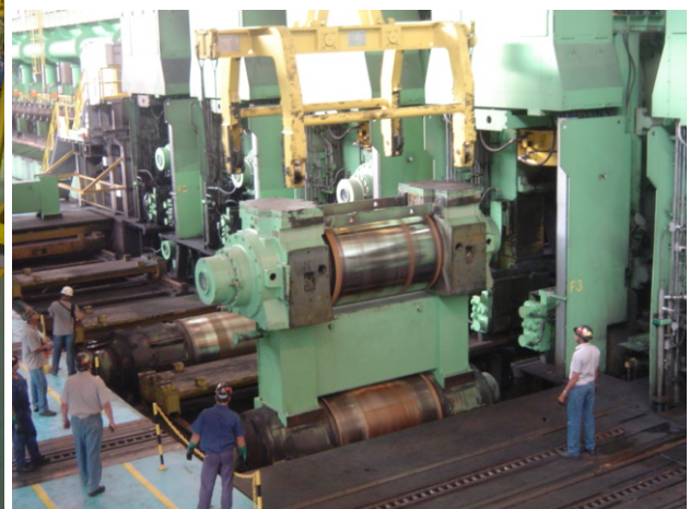
Figura 9. Troca de cilindros de encosto do trem acabador. No detalhe a barra de içamento, os cilindros de encosto inferior e superior e o cavalete de apoio (Stool) entre eles. A movimentação e utilização das pontes rolantes são estudadas antes de toda troca, visando o menor número de movimentações e o menor tempo de troca.
