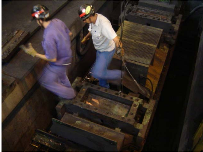
Figura 4. Retirada de calços inferiores dos cilindros de encosto do trem acabador. A retirada manual de um calço por vez, elevava o tempo de troca em aproximadamente 2h.
