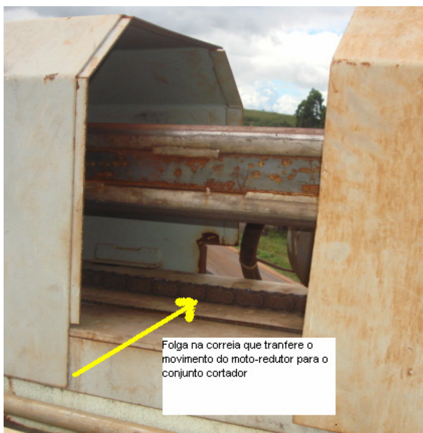
Figura 12 - Folga e falta de lubrificação
