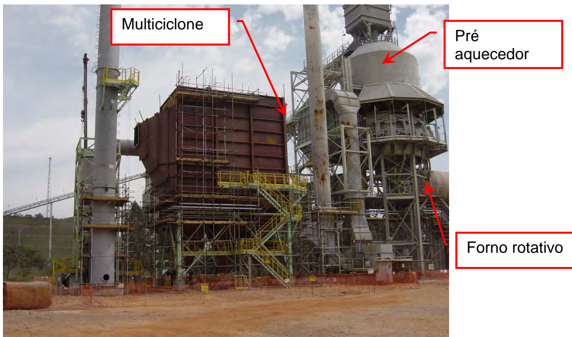
Figura 3. Foto da instalação do PE durante a fase de montagem.
