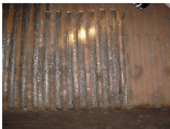
Figura 5. Relleno soldadura base Cr-Ni-Mo en campana móvil.
