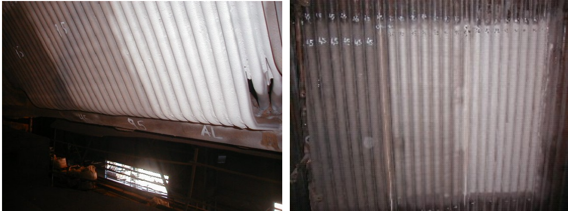
Figura 1. Metalizados Cr, Ni-Cr-Ti y Al en campanas móvil y corta.
