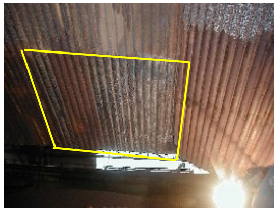
Figura 4. Ampliación de relleno soldadura E-6010 en campana móvil.
