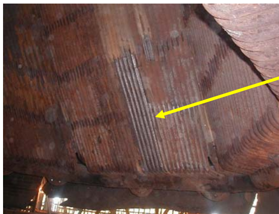
Figura 3. Relleno soldadura E-6010 en campana móvil.
