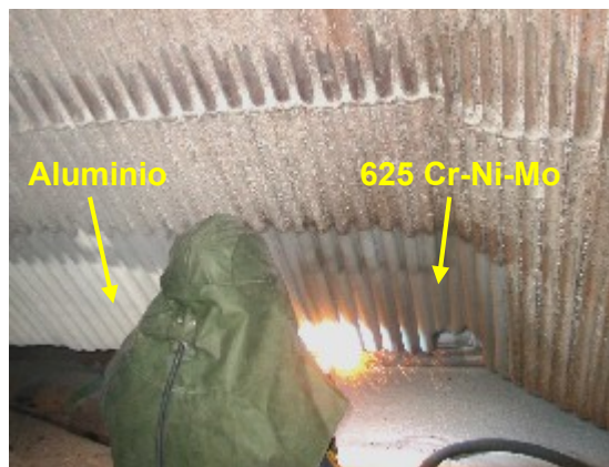
Figura 2. Metalizados Al y Cr-Ni-Mo en campana móvil.
