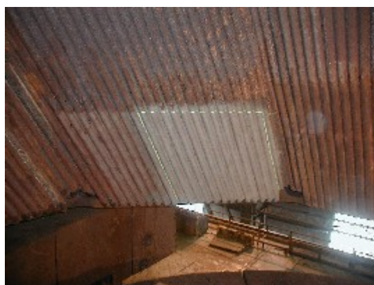
Figura 6. Metalizado base Cr-Ni en campana móvil.
