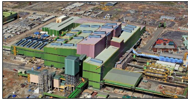
Figure 1. Steel plant ThyssenKrupp CSA.
