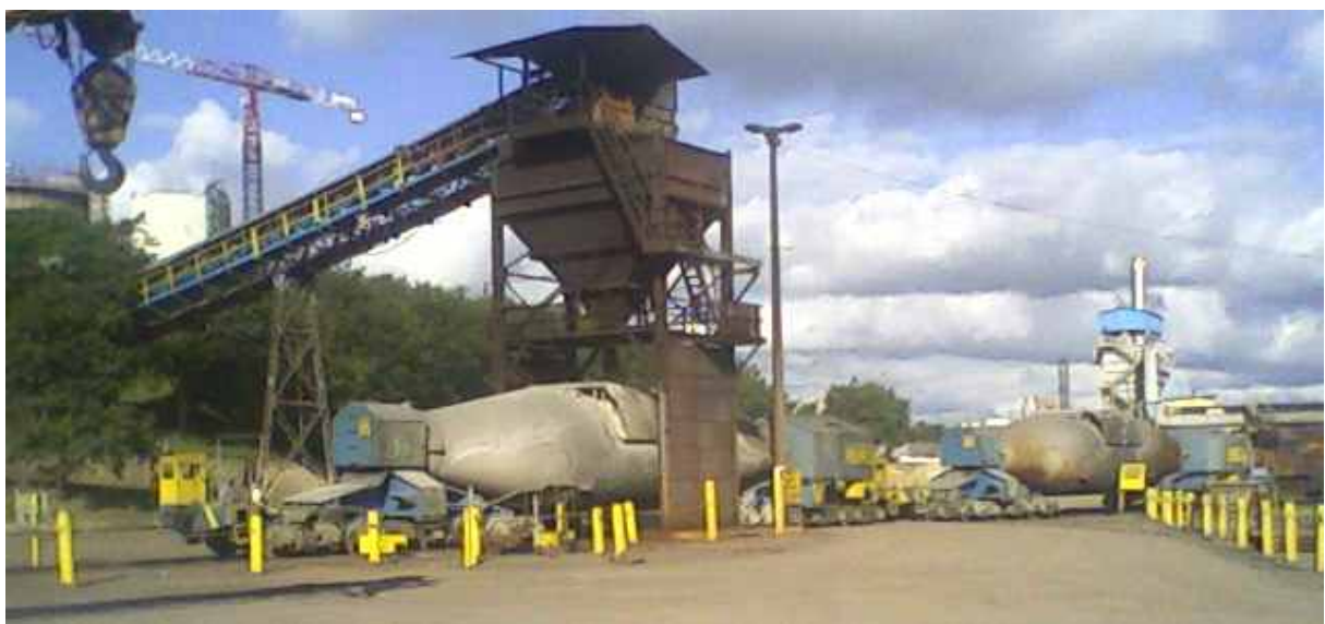
Figura 8 – Carregamento de Carro-Torpedo na estação de adição de pelota AR.
