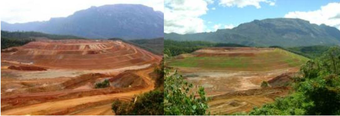
**Figura 1.** Imagem da Pilha de disposição de estéril (PDE01) localizada na Mina de Fabrica Nova antes e após do processo de plantio. Fonte: do autor.
