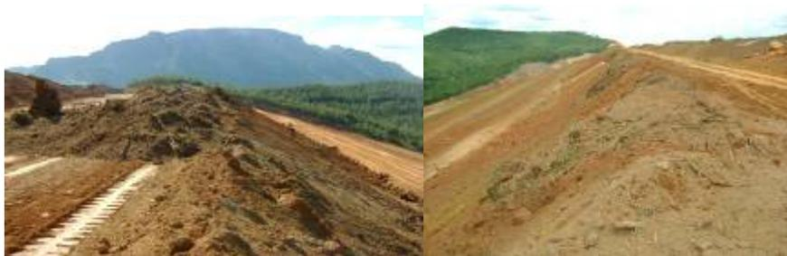
**Figura 6.** Aplicação de top soil no PDE01 na Mina de Fabrica Nova.
