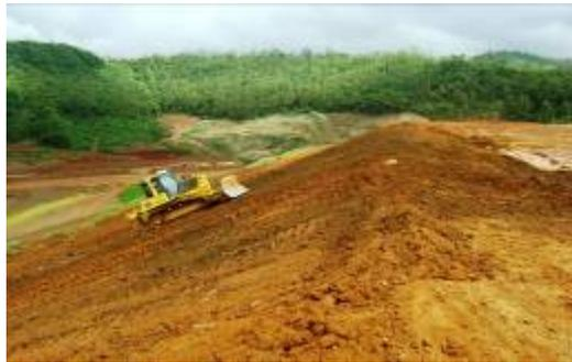
**Figura 4.** Processo de retaludamento realizado no PDE01 na Mina de Fabrica Nova.
