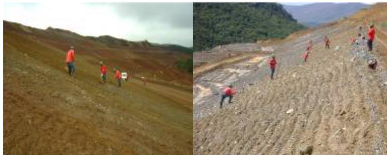
**Figura 8.** Taludes da pilha de estéril sendo preparados para o plantio.
