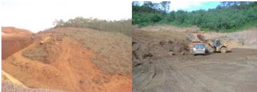
**Figura 5.** Remoção e transporte de top soil no PDE01 na Mina de Fabrica Nova.
