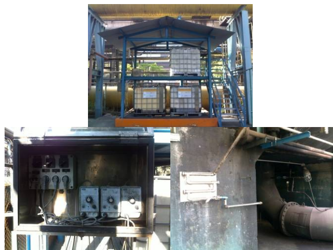
Figura 5 – Esquema de dosagem do Produto nos boosters.
