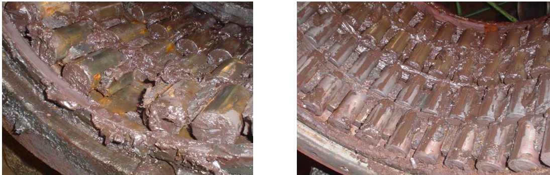
Figura 4. Situação de ressecamento da graxa
