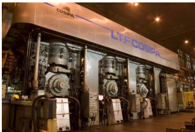
Figura 2 : Laminador de Tiras a Frio após reforma.
