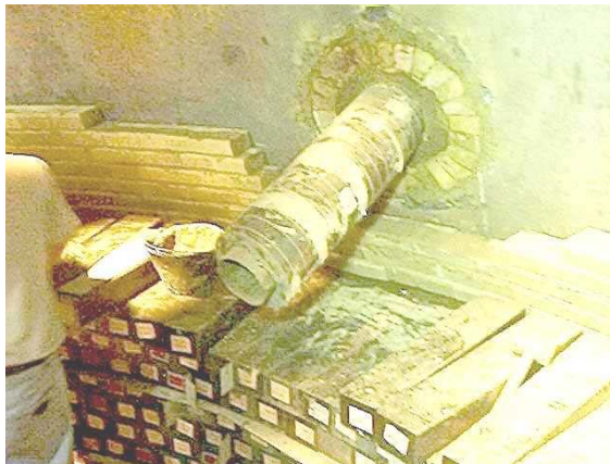
Figura 9. Pré-montagem do furo de corrida
