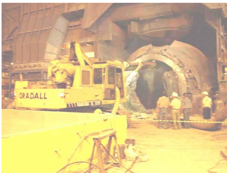
Figura 4. Demolição com conforto térmico para o operador.
