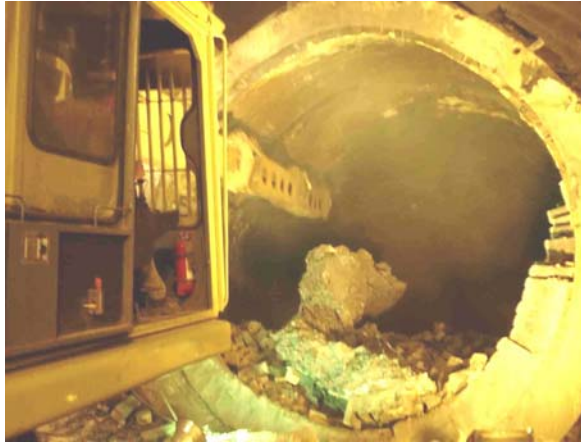
Figura 5. Demolição a frio do revestimento do conversor
