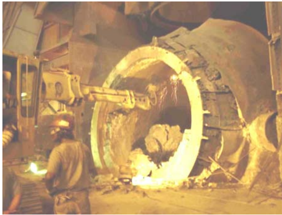
Figura 6. Demolição a quente
