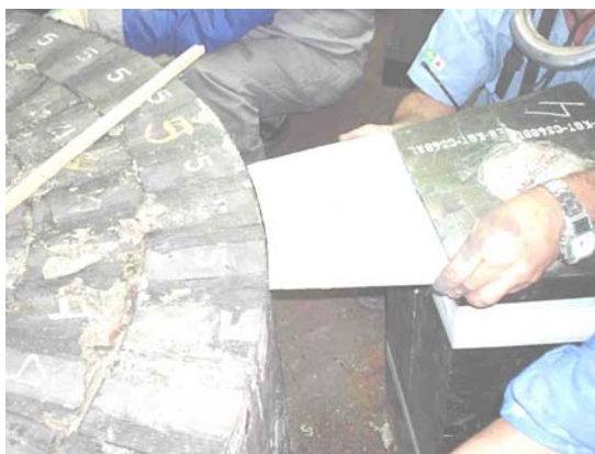
Figura 10. Procedimento de marcação do fecho da ventaneira.
