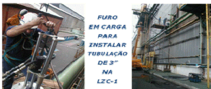
Figura 15. Ampliação da tubulação de refrigeração da LZC-1.
