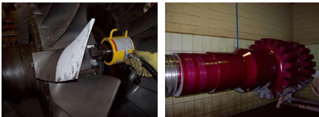
Figura 7 – Desmontagem das palhetas e ensaio de líquido penetrante eixo.
