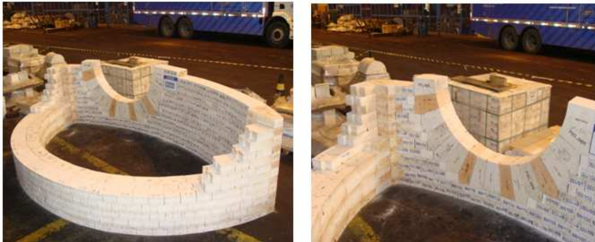
Figura 4 – Pré-montagem na CSN.
