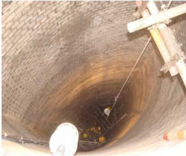
Figura 13 – Câmara de combustão reparada.
