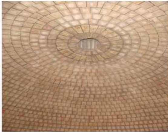
Figura 8 – Domo após o reparo
