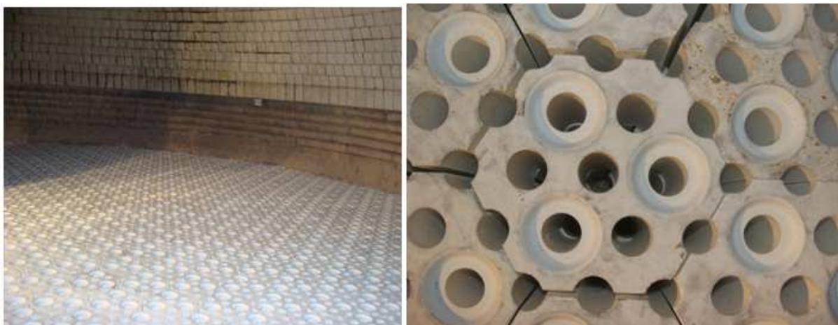
Figura 10 – Empilhamento após o reparo.
