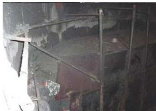
Figura 12. Aplicação da massa de socar na região de furo.
