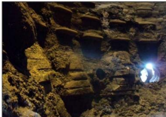
Figura 5. Tijolos de carbetos na região das ventaneiras. Remanescentes do reparo de 2010.
