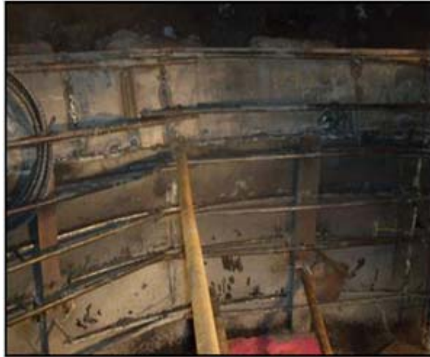
Figura 7. Fôrma montada para bombeamento do concreto.
