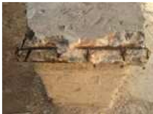
Figura 14 Removedor de ferrugem aplicado nas ferragens
