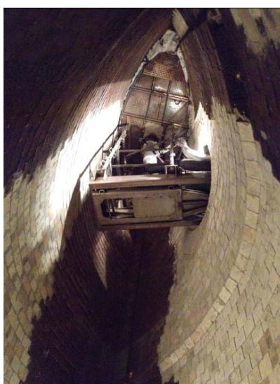
Figura 6 - Exemplo de reparo a quente em baixas elevações: Escudo térmico posicionado no bocal de ar quente. Detalhe da área reparada: Tijolos de coloração bege claro.
