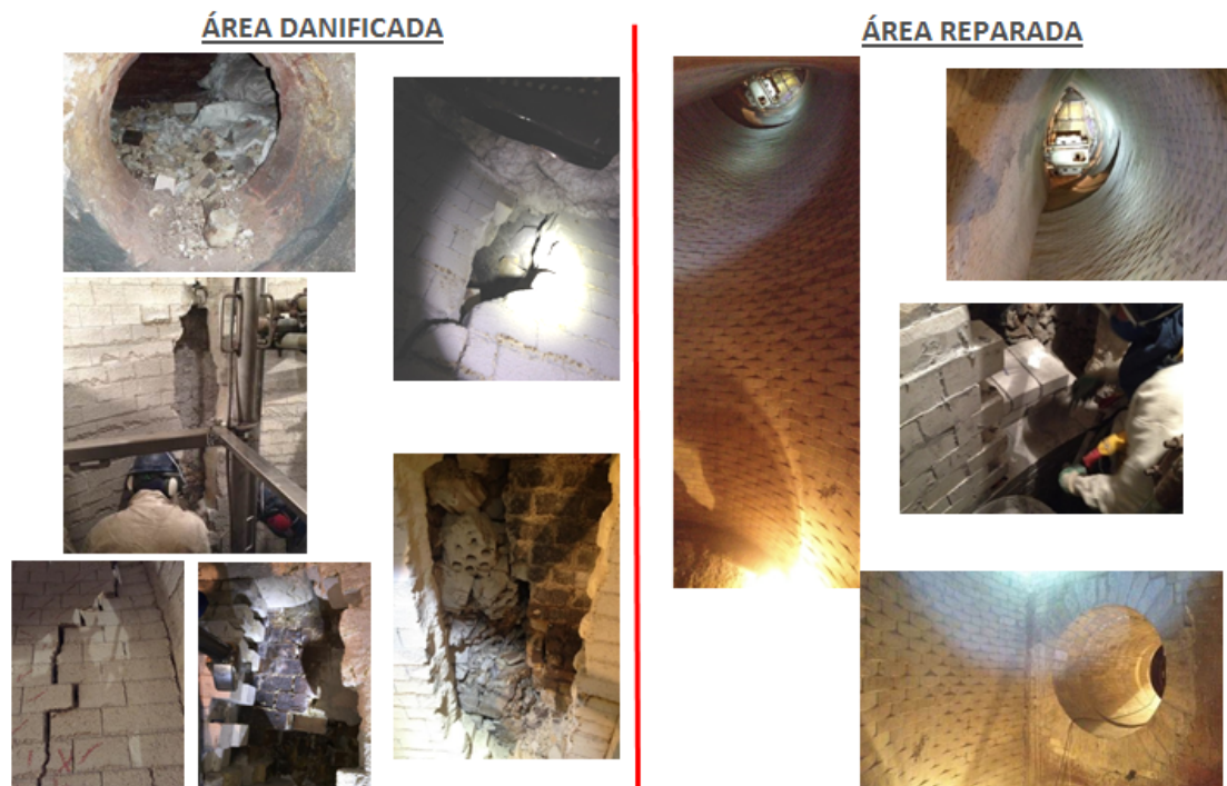
Figura 10 – Situação encontrada em altas elevações antes e após reparo a quente.
