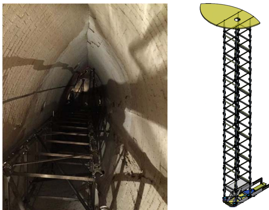
Figura 11 – Heat shield recém-instalado em alta elevação para início do reparo.
