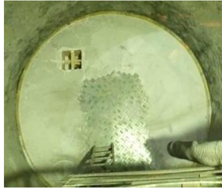
Figura 2: Revestimento do fundo da panela, com tijolos no impacto e monolítico concretado no local.
