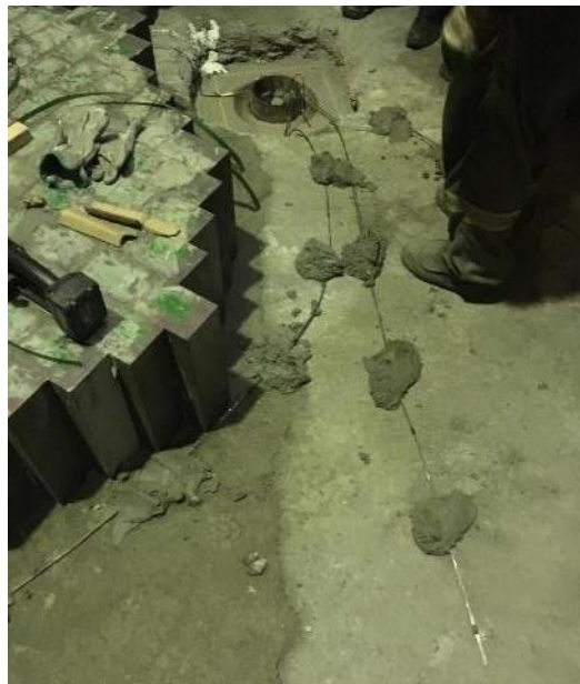
Figura 1: Tijolos do impacto montados no fundo da panela e termopares de controle instalados.
