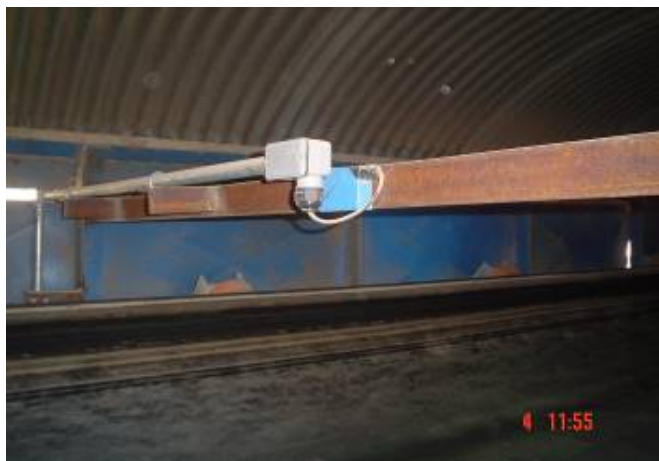
Figura 8: Montagem dos instrumentos de material sobre as correias
