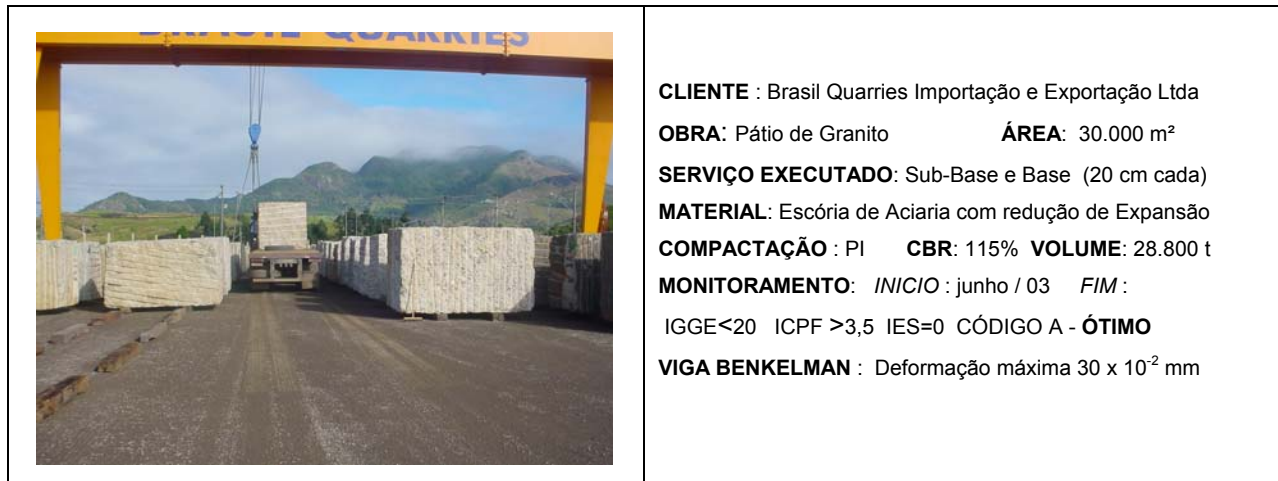
Figura 1 – Levantamento visual contínuo da obra do pátio de granito da Brasil Quarries Importação e Exportação Ltda
