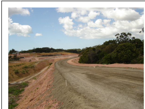
Figura 4 – Verificação da camada de base com ACERITA® na obra da Avenida Industrial (tráfego pesado) – Prefeitura Municipal da Serra/ES
