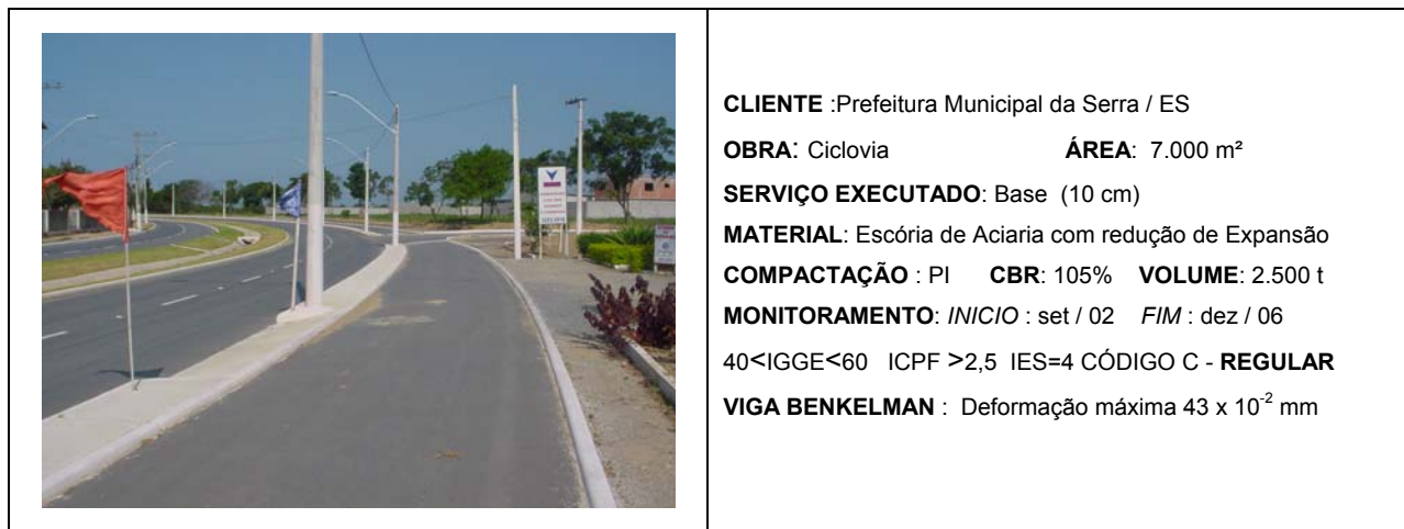
Figura 2 – Levantamento visual contínuo da obra da ciclovia – Prefeitura Municipal da Serra/ES
