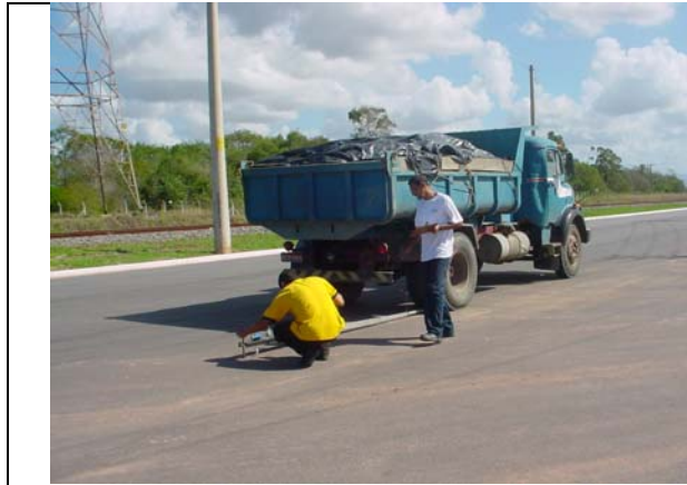
Figura 3 – Verificação com viga Benkelman da obra de pavimentação de vias internas – Terminal Industrial Multimodal da Serra - TIMS
