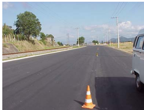
Figura 6. Vias pavimentadas sujeitas à tráfego pesado
