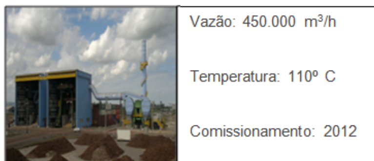
Figura 12. Despoejamento das Baías de Emergência.
