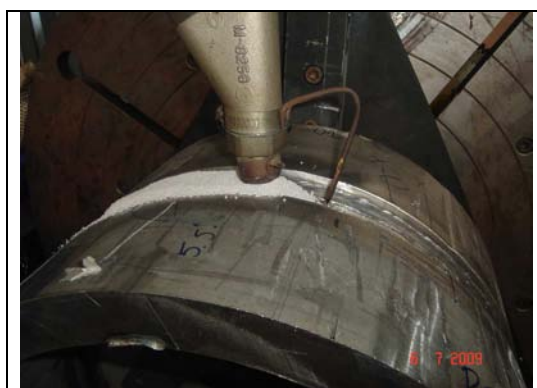
Figura 2. Realização da soldagem de enchimento na tubulação pelo processo SAW.
