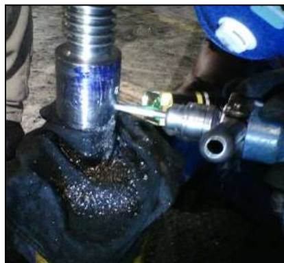
Figura 14. Furação final em conjunto haste nova com a haste velha, para montagem pino elástico Fonte: ArcelorMittal Tubarão (2013).
