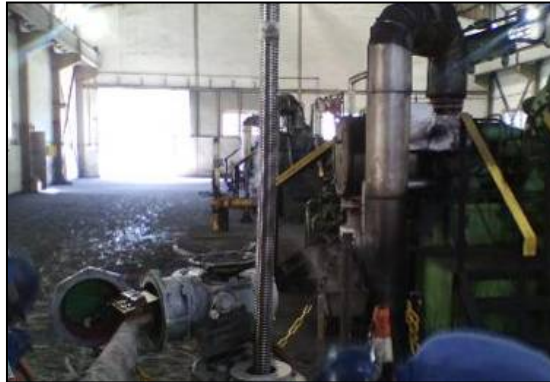
Figura 15. Haste nova montada na válvula Fonte: ArcelorMittal Tubarão (2013).
