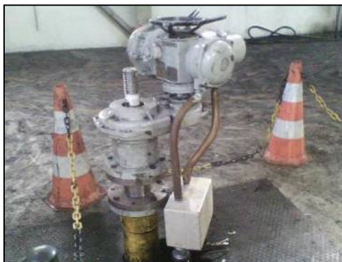
Figura 18. Carretel e atuador montado na válvula Fonte: ArcelorMittal Tubarão (2013).
