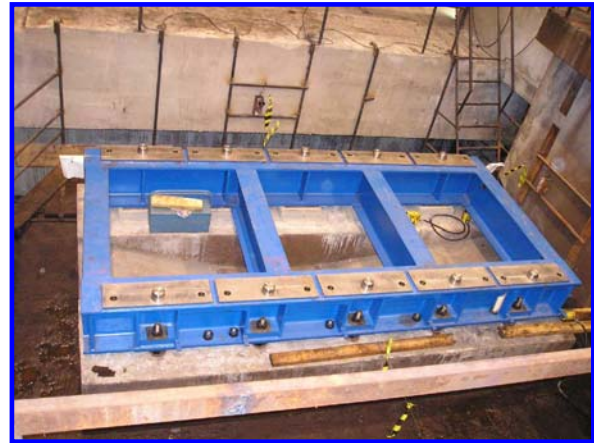
Figura 4 – Montagem da base metálica
