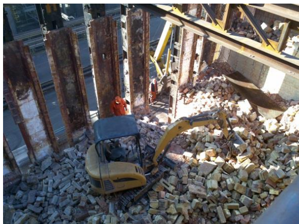
Figura 21 – Demolição completa da bateria
