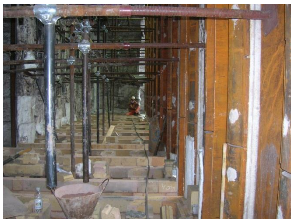
Figura 19 – Visão dos fornos em reforma
