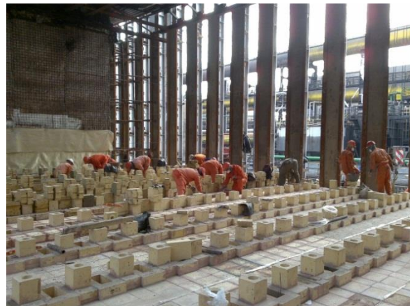
Figura 22 – Reconstrução das paredes
