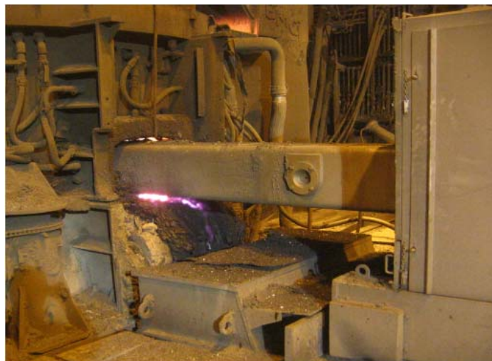
Figura 2 – MOTANK em operação de limpeza do barrado
