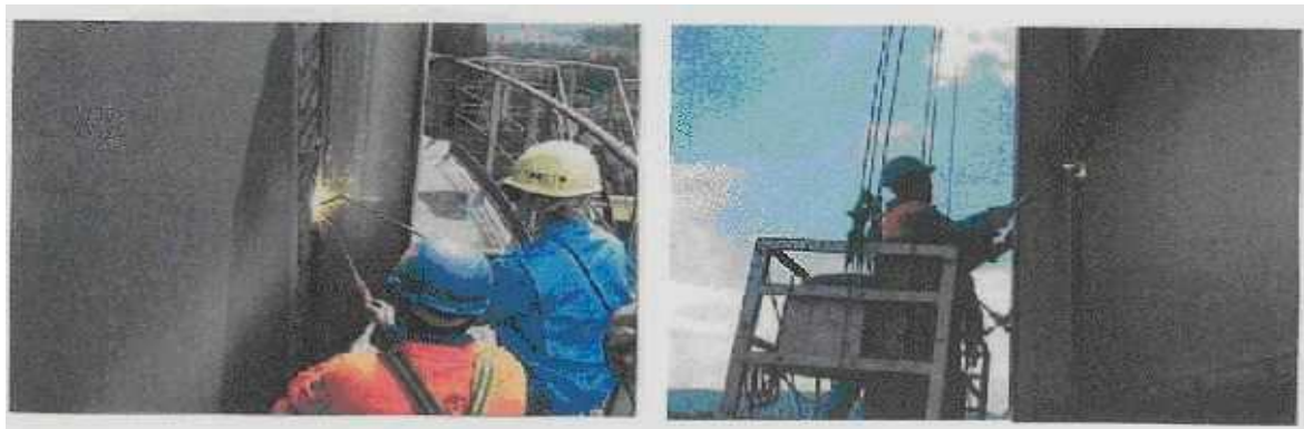
Figuras 6 e 7. Reparo das chapas do costado.
