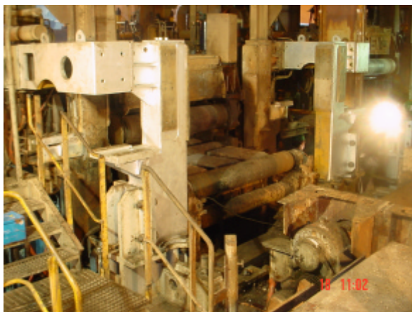
Foto 5 – Nueva estructura para alojamiento segmento 15 y rodillo provisorio
