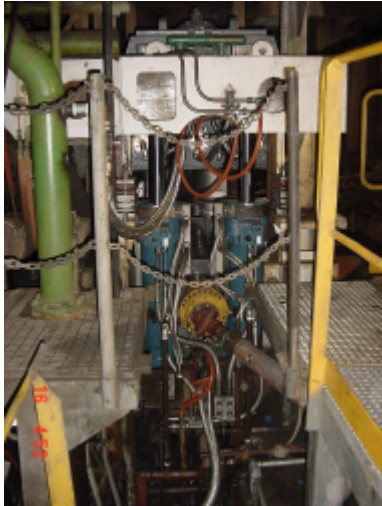
Foto 11 – Vista lateral segmento 15
