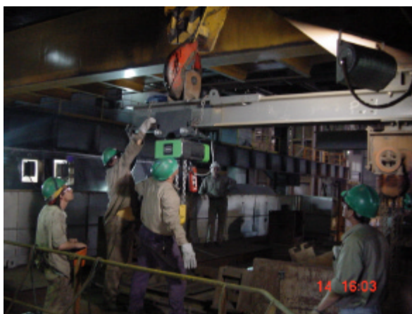
Fig. 7 = Foto 7 – Montaje aparejo a cadena Fig. 8 = Foto 8 – Montaje segmento 15
