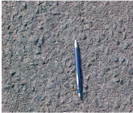
Figura 2. TST sem capa selante.
