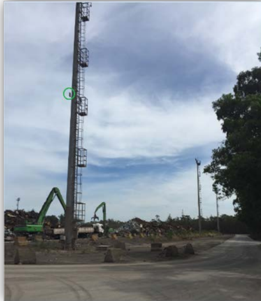
Figura 9. Antena WiFi instalada no pátio de sucatas
