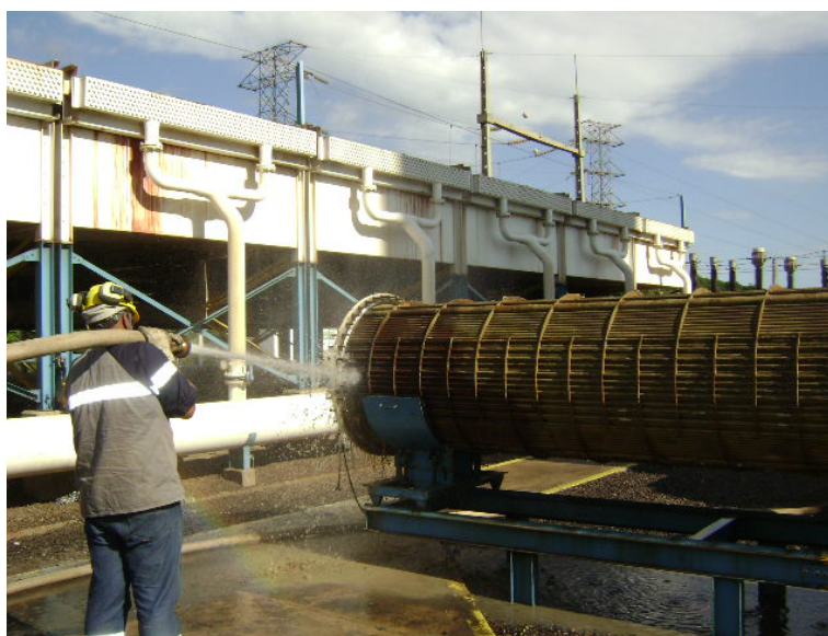
Figura 9: Limpeza externa dos tubos do trocador E07 em 2011.
