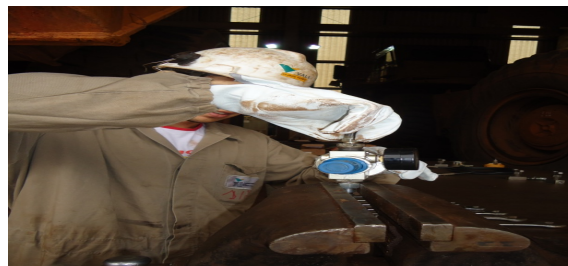
Figura 11. Montagem do dispositivo
