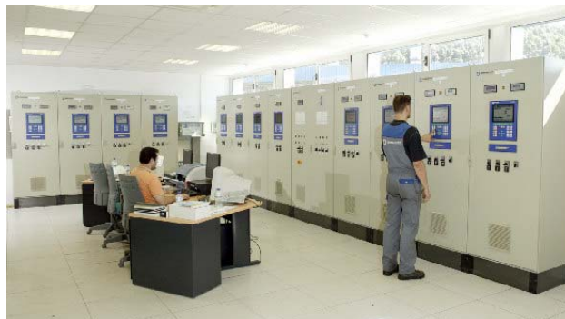
Figura 8: Sala de controle.
