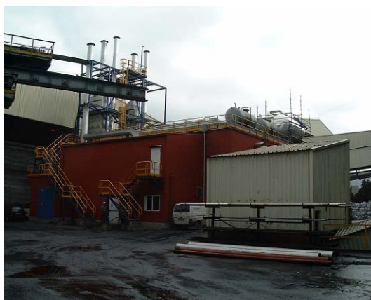
Figura 4: Casa de máquinas, planta de 4 MWe; Asturias, Espanha
